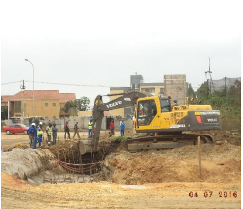
Ouverture de réseaux de canalisation
